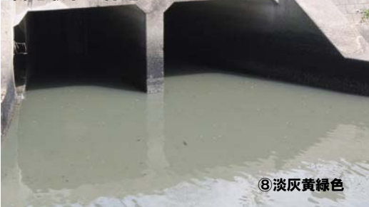
向田橋南 留池取水口付近
