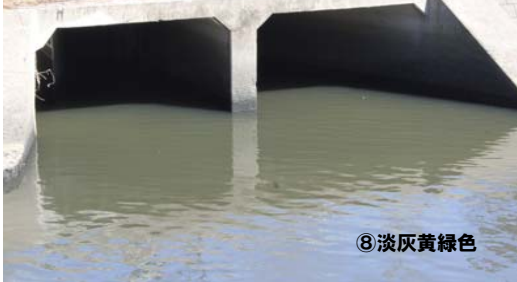
向田橋南 留池取水口付近
