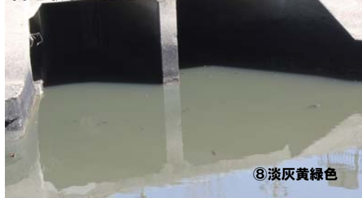
向田橋南 留池取水口付近
