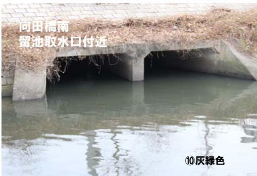
向田橋北 堀留水処理センター方面
