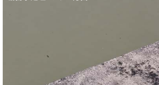
向田橋北 堀留水処理センター方面
